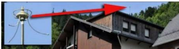
Paratonnerre Hélita à pastille non impacté par le premier sinistre.
